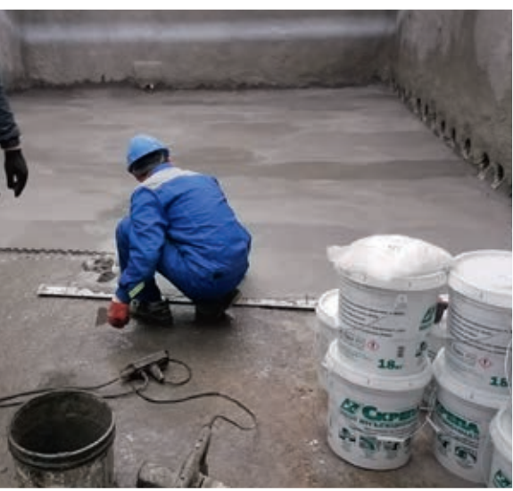
Ремонт песчаного фильтра с применением материалов системы Скрепа
