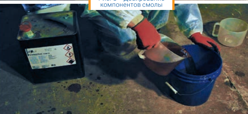
Рис. 3 – Дозирование компонентов смолы
