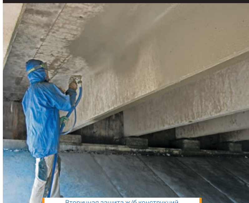
Вторичная защита ж/б конструкций на автодороге Р-215 Астрахань-Махачкала
