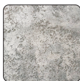
ШТУКАТУРКИ НА ЦЕМЕНТНОЙ ОСНОВЕ
