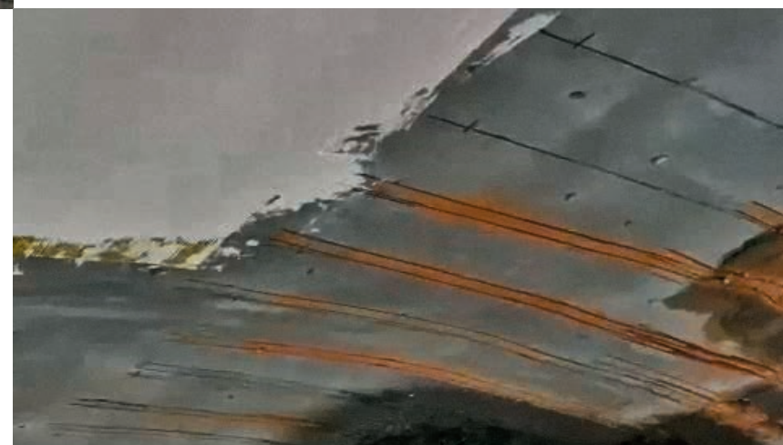
Примыкания «стена/плиты перекрытия» и участки оголенной арматуры в ходе ремонта
