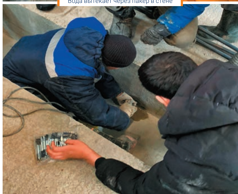
Вода вытекает через пакер в стене
