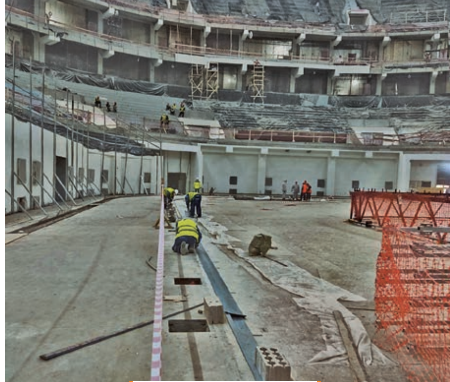
Монтаж системы Пенебанд С
