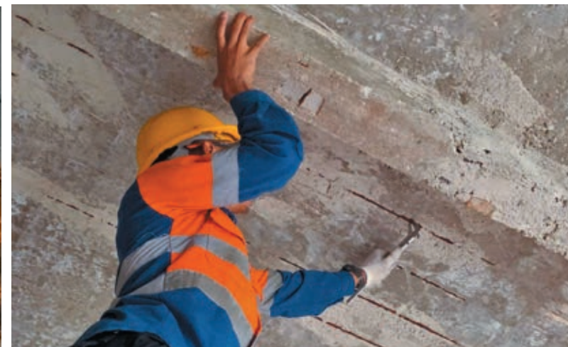
Примыкания «стена/плиты перекрытия» и участки оголенной арматуры в ходе ремонта
