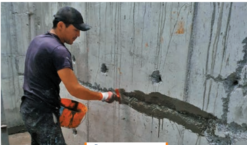
Гидроизоляция швов
