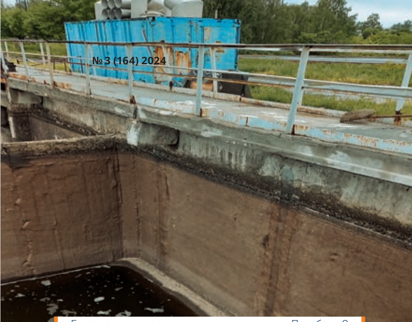
Гидроизоляцию аэротенков держит система Пенеканд С
