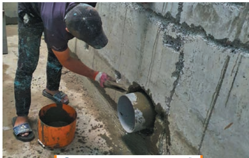
Гидроизоляция вводов коммуникаций
