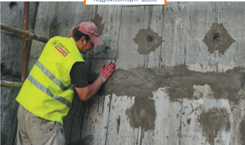
Гидроизоляция швов
