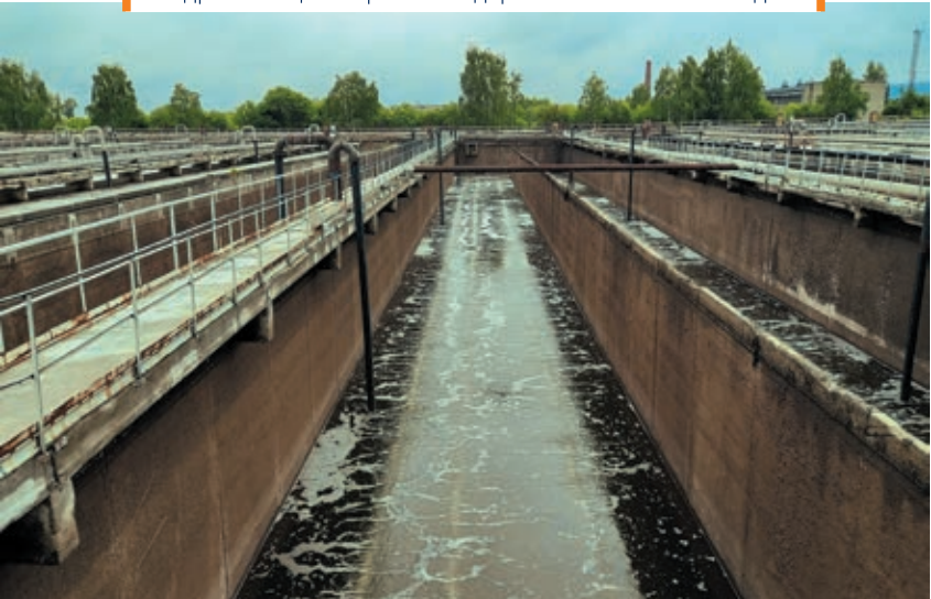
Гидроизоляцию аэротенков держит система Пенеканд С
