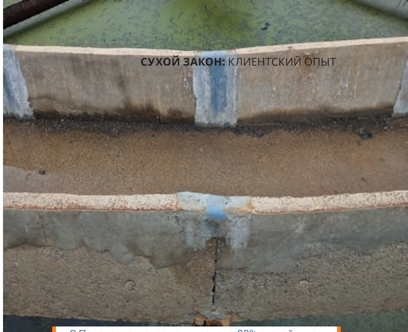
С Пенетроном отремонтировано 80% отстойников
