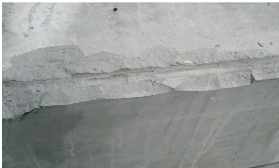
Рисунок А1.1.2 – Поверхностные дефекты бетона
