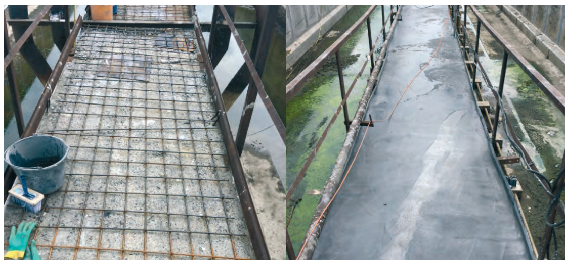
Рисунок А.1.4.3 – Ремонт плит проходных мостиков.
