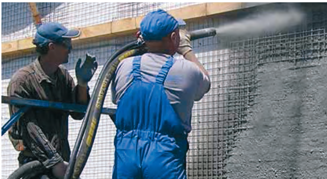
Рисунок В.1 – Сухое торкретирование
