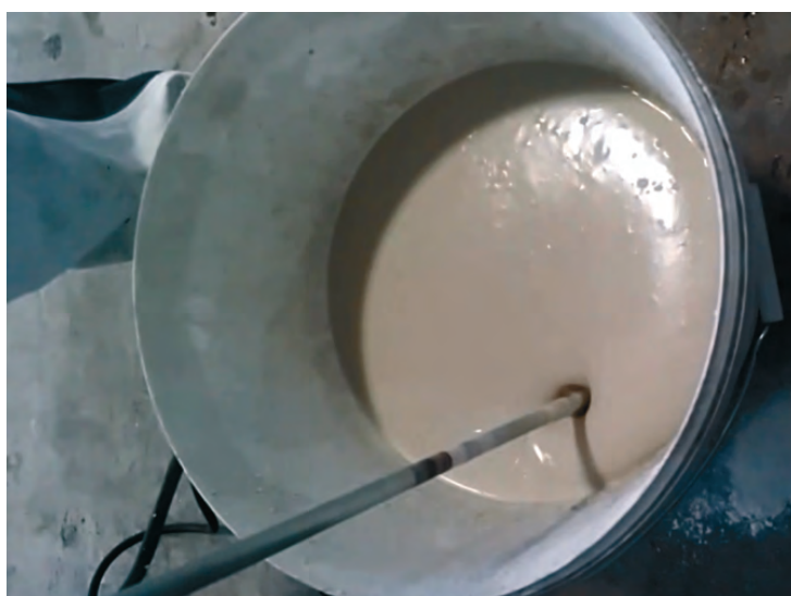
Рисунок В.5 - Приготовление растворной смеси «Скрепа 2К Эластичная»
