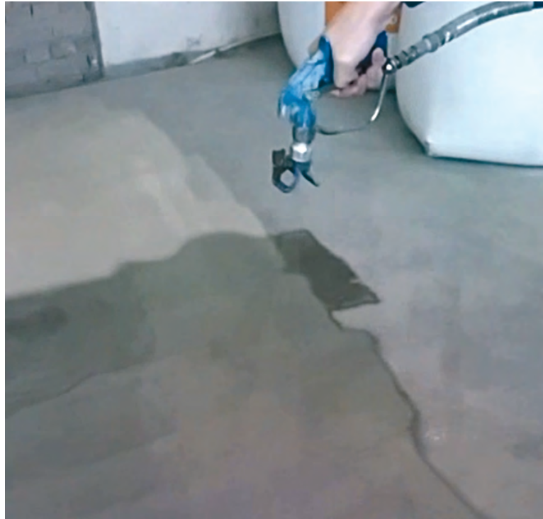
Рисунок В.6 - Нанесение растворной смеси «Скрепа 2К Эластичная» аппаратом безвоздушного нанесения
