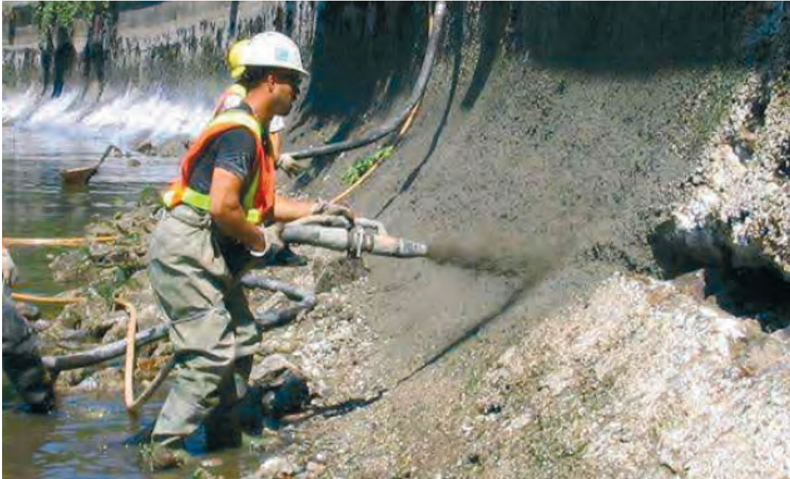
Рисунок В.2 – Мокрое торкретирование
